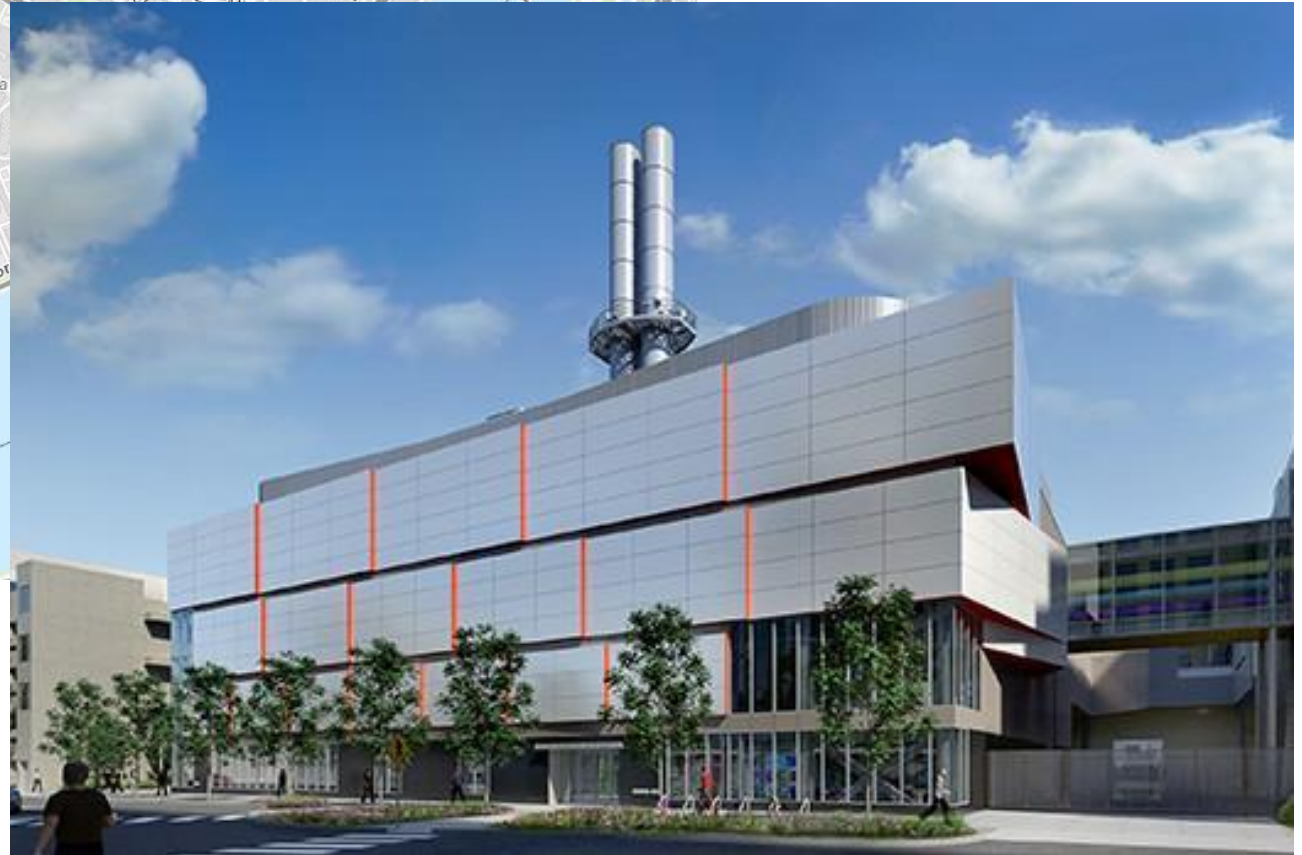
MIT Central Utilities Plant Upgrade (2020)
